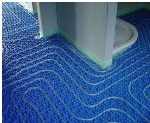
Slika. Montaža podnog grijanja
