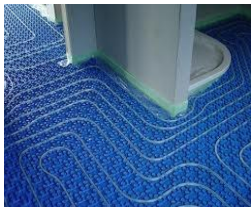
Slika. Montaža podnog grijanja
