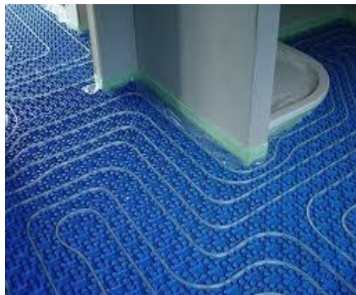
Slika. Montaža podnog grijanja
