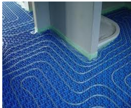
Slika. Montaža podnog grijanja
