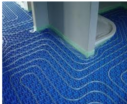
Slika. Montaža podnog grijanja
