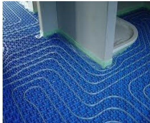
Slika. Montaža podnog grijanja
