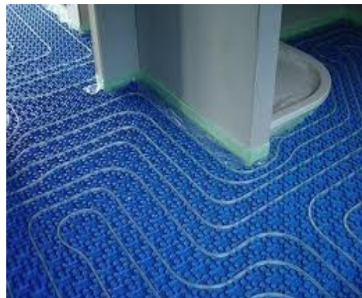
Slika. Montaža podnog grijanja
